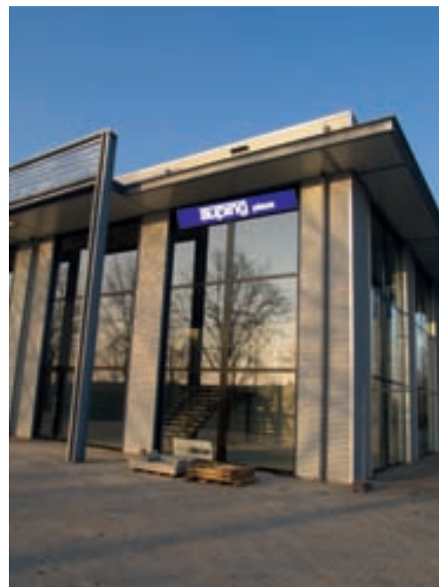
De uitbreiding aan de Engelseweg is gerealiseerd en de eerste bedrijven zitten er al in, Helmond
