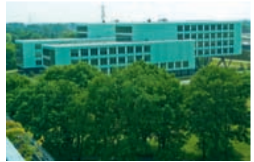
Atos Origin gebouw op de High Tech Campus, Eindhoven
